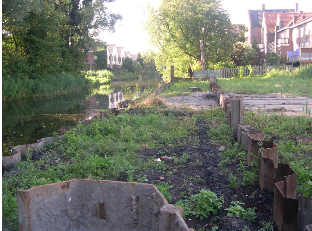
Afb. 3: De opgravingsput omgeven door een damwand
