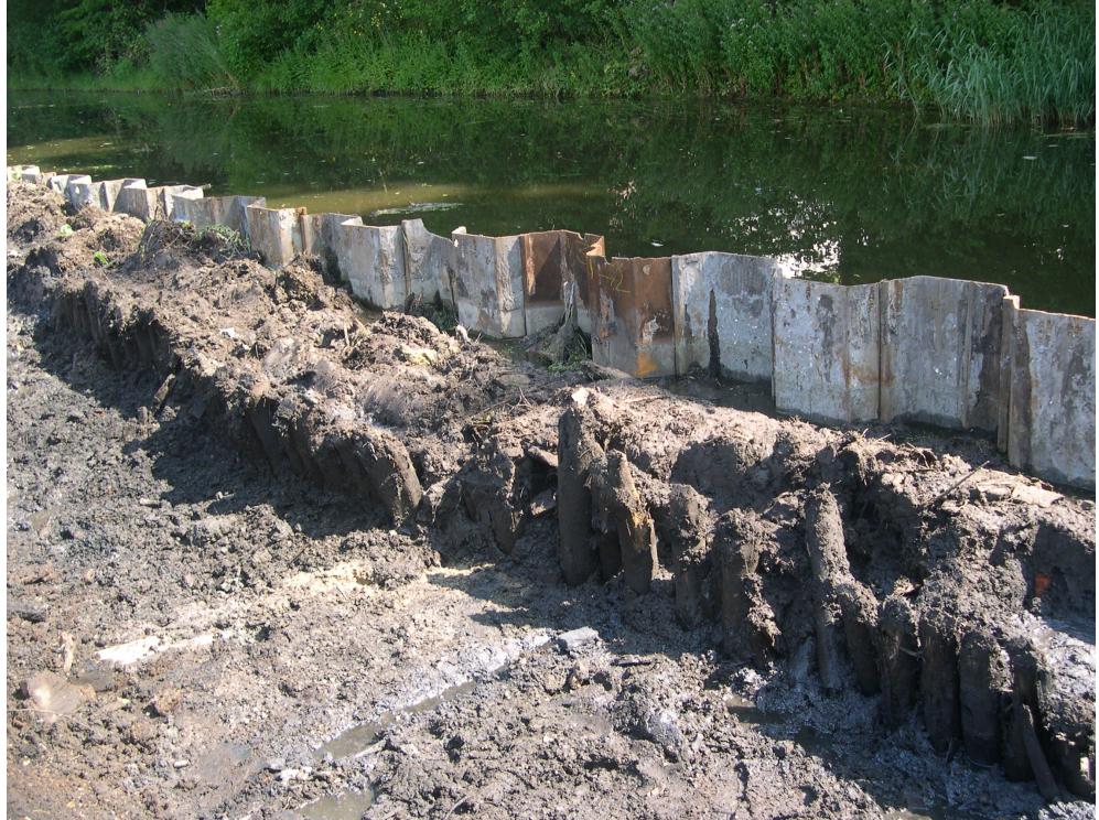
Afb. 8: Overzicht van de kadebeschoeiing centraal in de put
