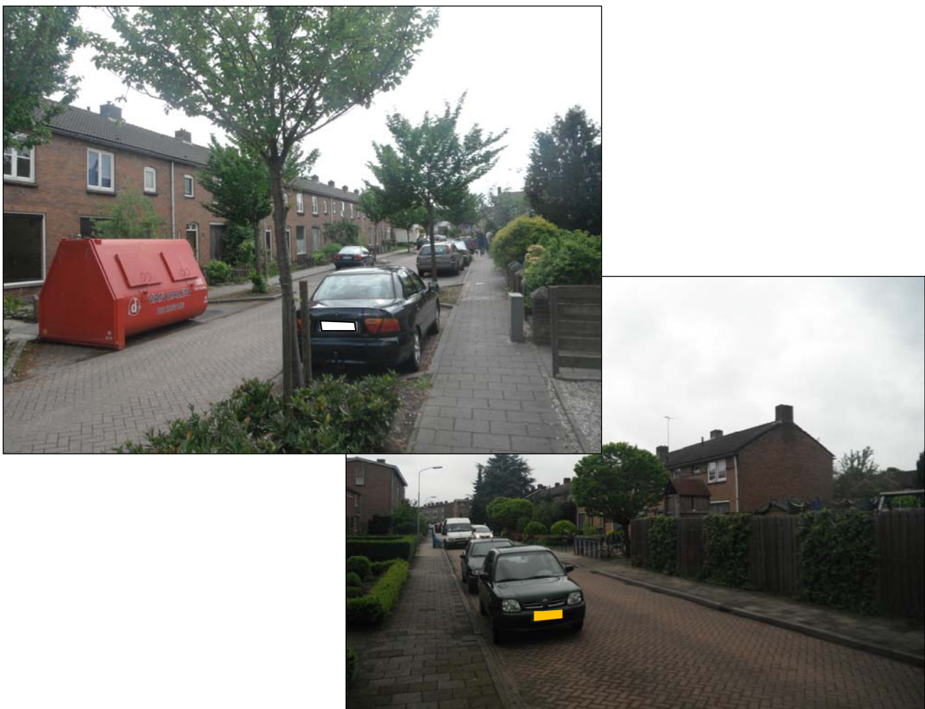
Figuur 2: plangebied bij aanvang van de werkzaamheden, Van Kleefstraat boven, Van Gelrestraat onder.
