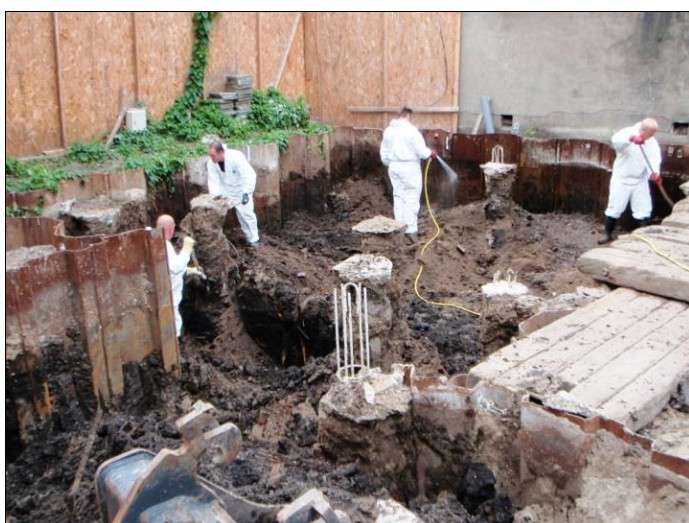
Afbeelding 9. Voorbereiding voor het stempelen van de damwanden, halverwege het onderzoek. Links het van de verontreinigde grond schoonspuiten van de damwanden, rechts het koppen van de heipalen
