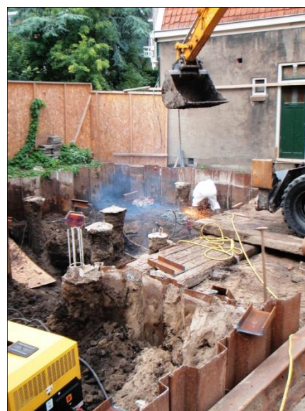
Afbeelding 9. Voorbereiding voor het stempelen van de damwanden, halverwege het onderzoek. Links het van de verontreinigde grond schoonspuiten van de damwanden, rechts het koppen van de heipalen
