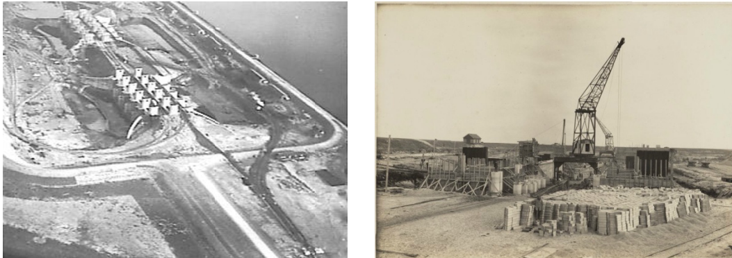
Afb. 7. Foto's van de bouw van de spuicomplexen uit ca 1930 met de tijdelijke ringdijken bij Den oever (links) en Kornwerderzand (rechts)
