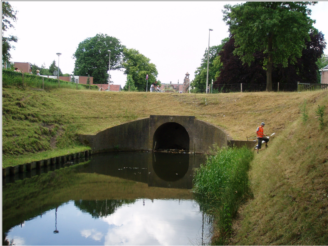
Figuur 7: Steenwijk, Gasthuispoort II: foto van de kruissing van de Vendelweg met de singelgracht. Rechts van de duiker wordt boring 5 uitgevoerd.
