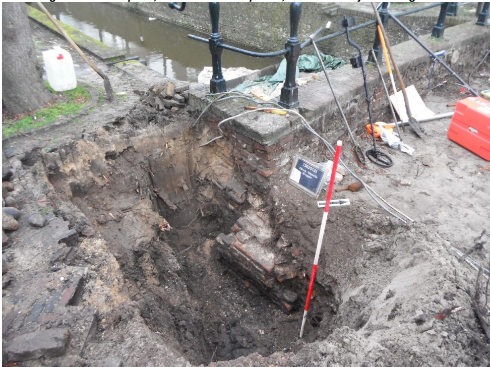
Afbeelding 31 werkput 3, overzicht vlak en profiel, in zuidwestelijke richting
