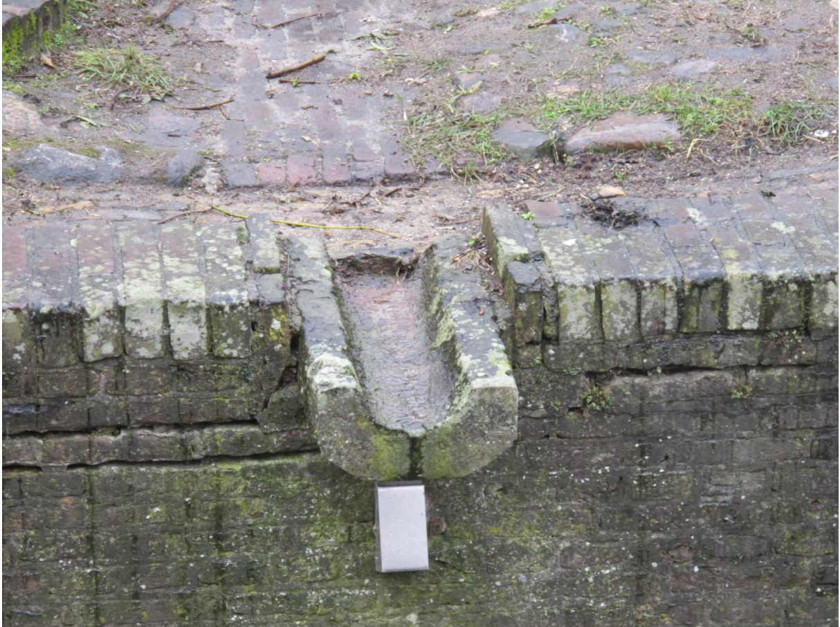
Een oudere spuwer in het vak tussen Oosterwalstraat en Noorderkerkstraat. FH MAB 25-2-2015
