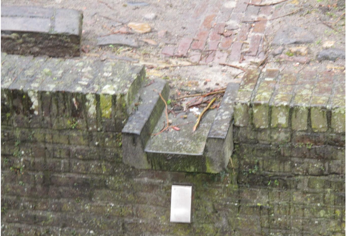
De meeste waterspuwers van de straatgoten zijn in het verleden vernieuwd in deze strakke vorm. FH MAB
