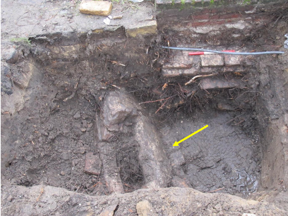
Zicht op de duiker en rechtsboven de funderingsrestant bij de hoek kademuur en brugwand. De bakstenen vloer van de duiker steekt buiten het gewelf uit (gele pijl). FH MAB 25-2-2015
