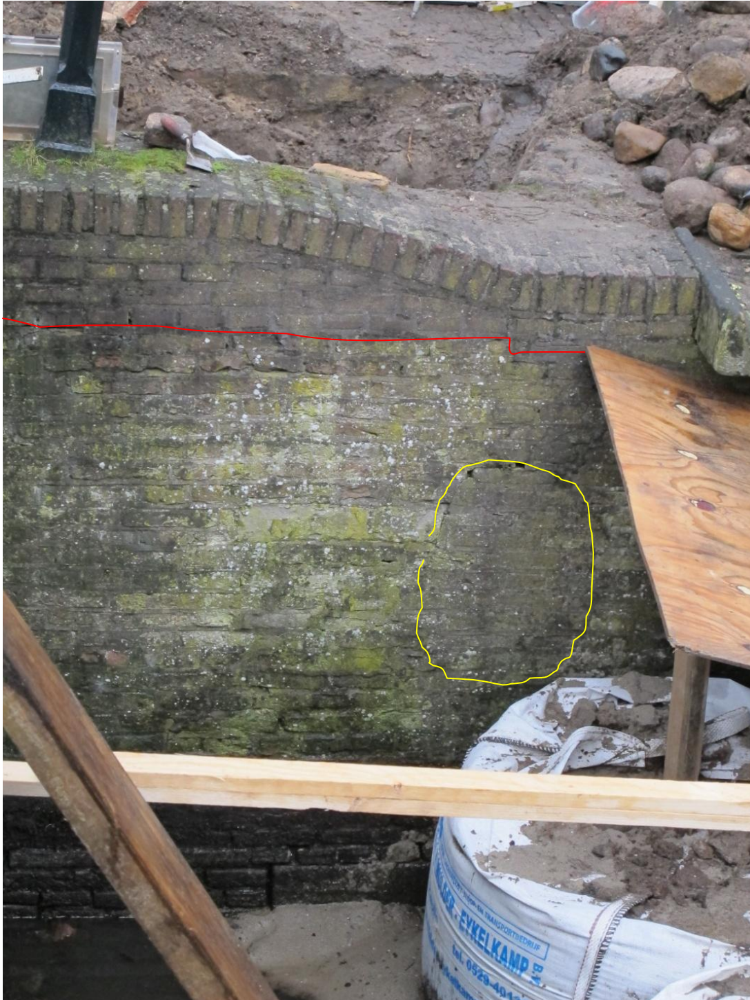
Afbeelding 13 Zicht op de kademuur, met geel omkaderd de dichtzetting van de uitwatering van de gevonden duiker. Boven de rode lijn is het metselwerk vernieuwd in machinale baksteen. Foto F.Haans 25-2-2015
