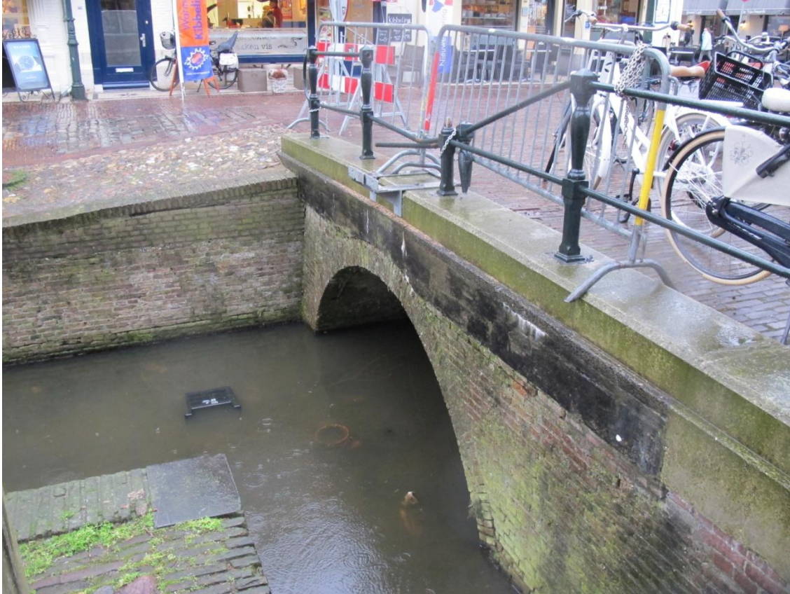
Brugfront met betonnen bovendeel van de brug bij de kruising Jufferenstraat en Beekstraat. FH MAB 2015
