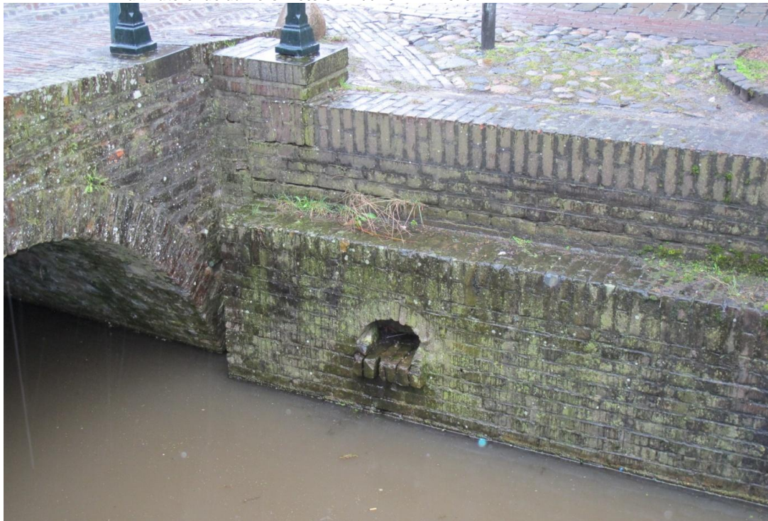
Afbeelding 14 In de kademuren nabij de brug van de Oosterwalstraat (kort voor de Mheenpoort (boven) en de kademuur net buiten de Goorpoort (onder) zijn nog openingen voorhanden van hier op de beek uitwaterende duikers. Foto's F.Haans MAB 2015
