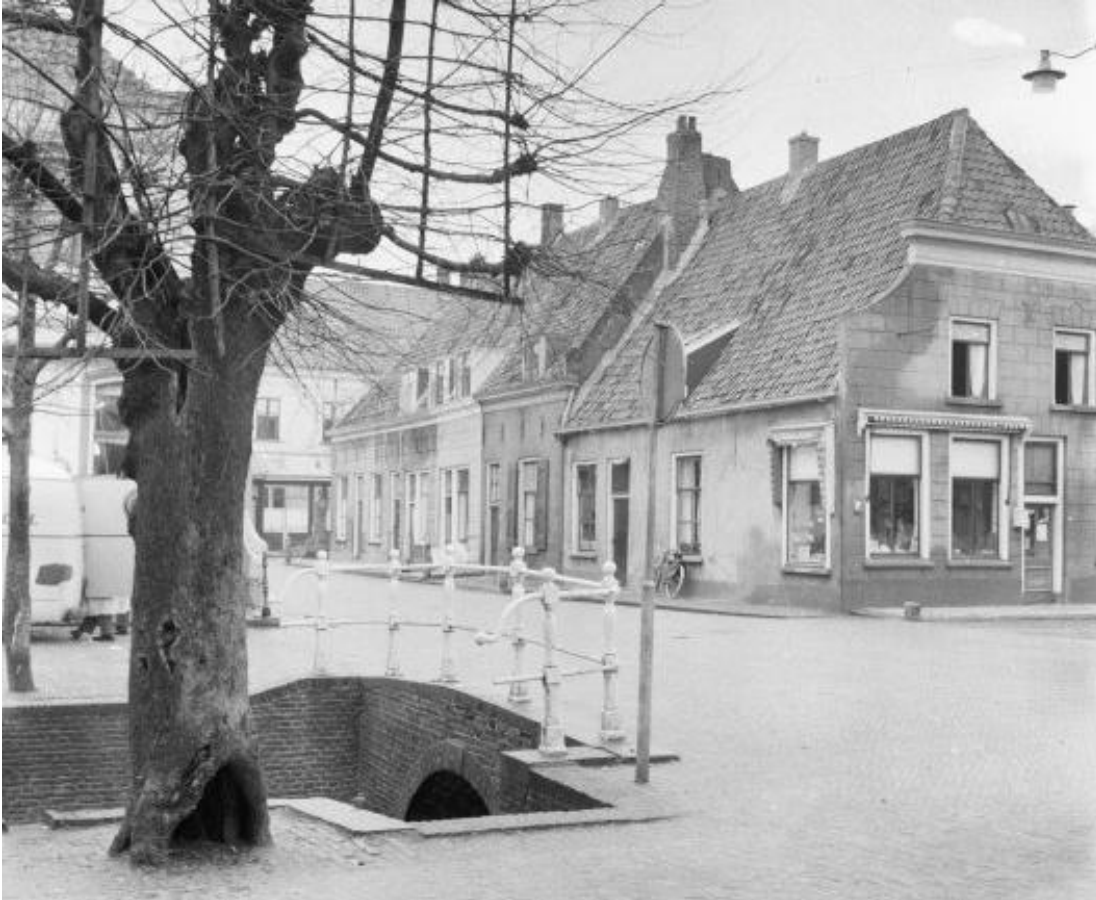
Brug bij Beekstraat, kruising Van Kinsbergenstraat/Noorderkerkstraat naar het noordwesten (Noorderkerkstraat) gezien. Foto G. Dukker 1962 Coll RCE
