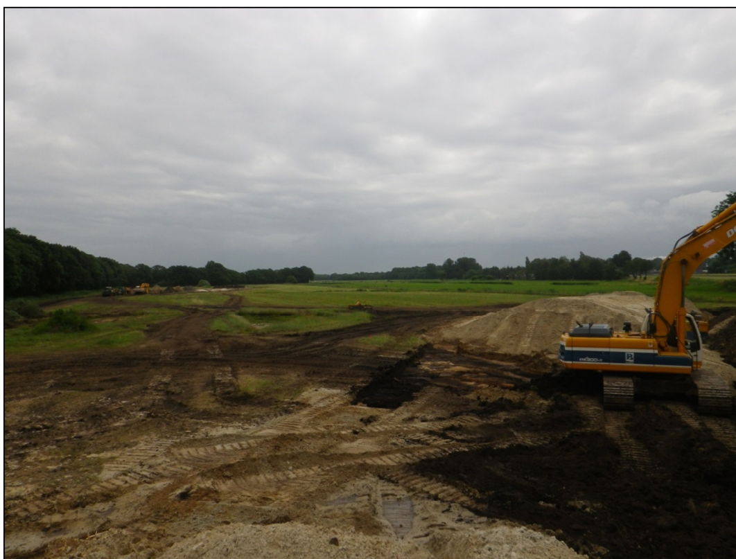
Afbeelding 3. Het plangebied bij aanvang van de werkzaamheden, gezien naar het oosten
