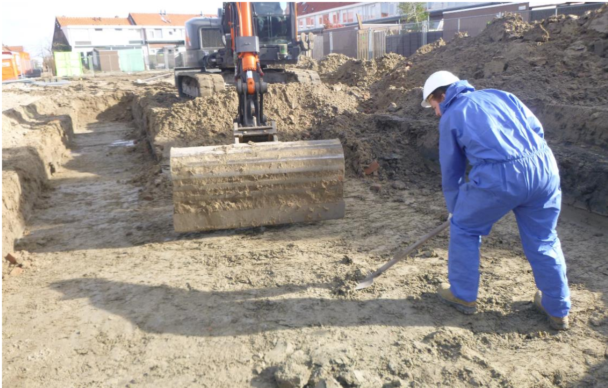
Figuur 3. Aanleg van WP8. De foto is richting het noorden genomen.
