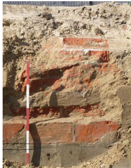
Figuur 4. Bodemopbouw ter plaatse van de fundering van een buitengevel. De oorspronkelijke bouwvoor bevindt zich tussen de twee zwarte lijnen.
