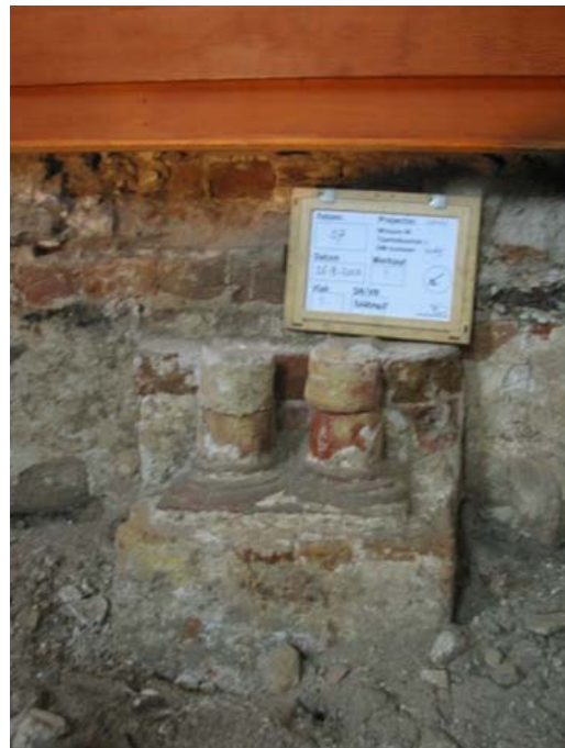
Afbeelding 20. Poer 03 (foto richting het zuidoosten).
