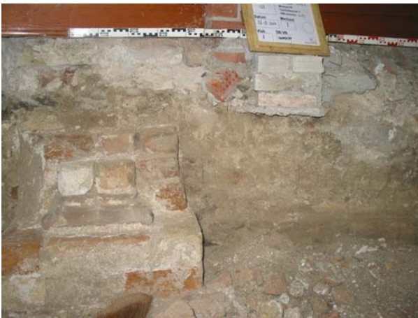
Afbeelding 19. Poer 02 (foto richting het zuidoosten).
