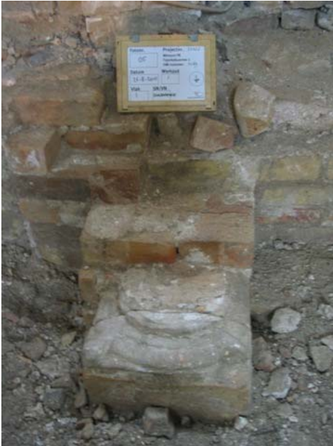
Afbeelding 21. Poer 04 (foto richting het zuiden).
