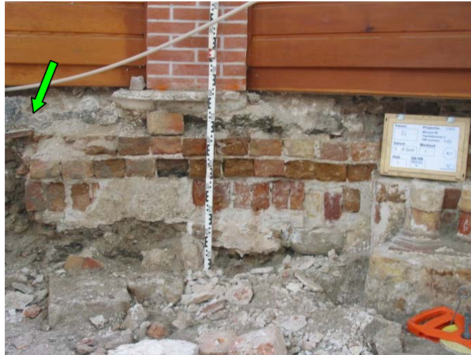
Afbeelding 14. Profiel IV. Aan de linkerkant een versnijing waarboven een losse plavuiz te zien is (pijl; foto richting het zuidoosten).
