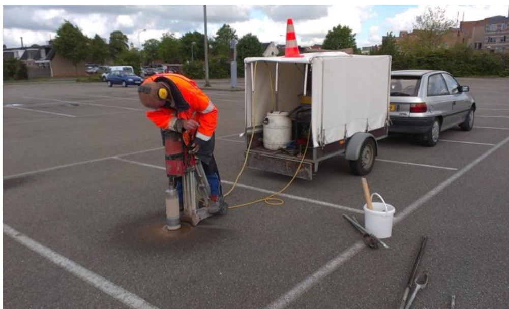
Afbeelding 8. Een foto van het veldwerk: het voorbereiden van de gaten met een betonboor
