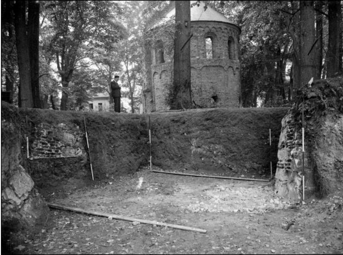
Figuur 17. Foto uit 1943 met de ontgraving ten behoeve van de oostelijke bunker (bron: Valkhofbunker.nl).
