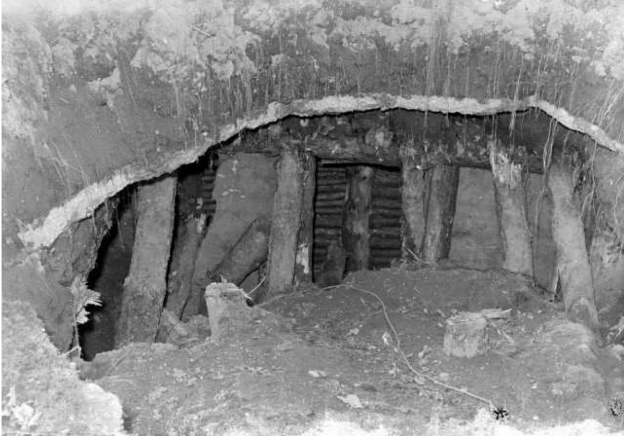
Figuur 13. Verzakkingen en grote gaten in het park als gevolg van de in de Tweede Wereldoorlog aangelegde loopgraven. Bron: Fotocollectie Regionaal archief Nijmegen; valkhofbunker.nl.
