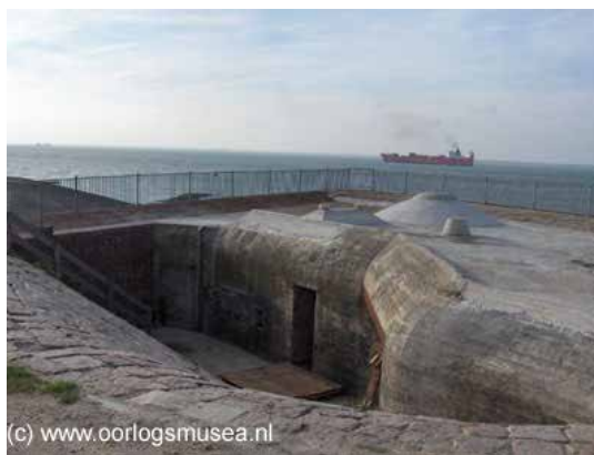
Fig.17 WO II bunker op de Oranjedijk. De verdedigingswerken langs de dijk hebben lokaal de oudere bewoningsresten grotendeels vernietigd.
