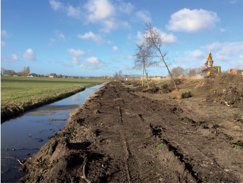
Afbeelding 4: kadevak Duifpolder Noord na het rooien van de bomen.
