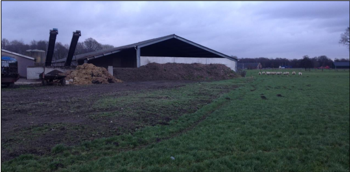
Figuur 9. Aanzicht van het nieuw te bebouwen gebied, waar boringen 1-5 geplaatst zijn.
