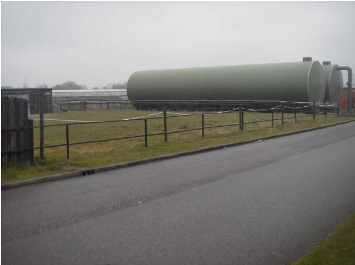
Figuur 13: Het plangebied gezien vanuit het zuidwesten
