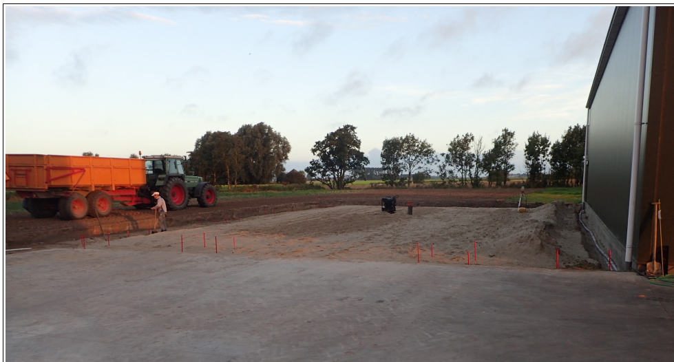
Figuur 2. Eenrum, Oosterweg 7: Het plangebied voorafgaand aan de graafwerkzaamheden. In het midden zichtbaar het onderzoeksgebied, waarvan de bovenlaag al is ontgraven en grotendeels is opgevuld met zand. Links de in 2014 gebouwde loods, waar de nieuwe loods tegenaan wordt gebouwd.
