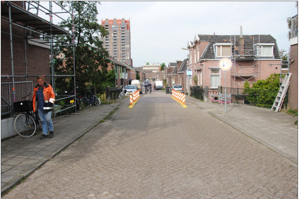
Afbeelding 2. Brug 201. Foto vanaf de Hogendijk richting noorden.
