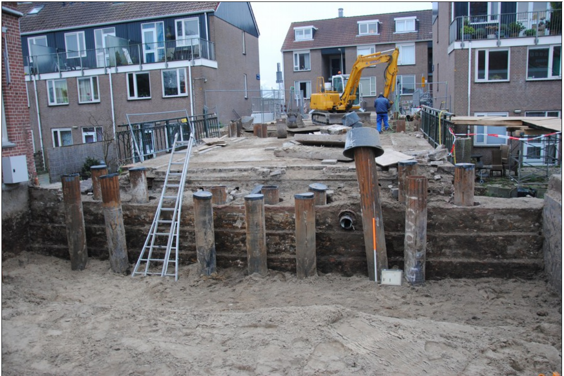
Afbeelding 4. Brug 201, Het bruggenhoofd aan de noordzijde. Foto richting zuiden.
