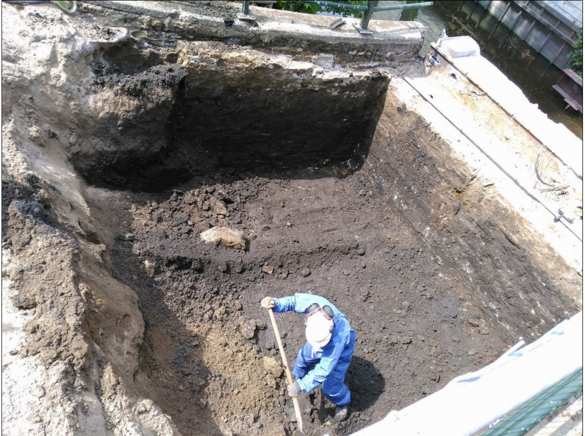
Afbeelding 7. Brug 202, Het bruggenhoofd aan de zuidzijde.
