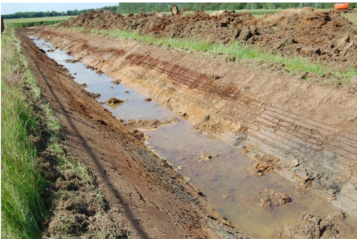
Afb. 4: Impressie van het profiel ter plaatse van een schuin talud, locatie Meesterijweg (Foto: Grontmij).
