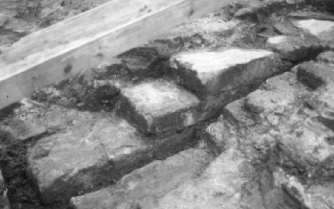
Afb. 12. Detail van de natuurstenen buitenschil van de middeleeuwse stadsmuur, ongeveer op de waterlijn.
