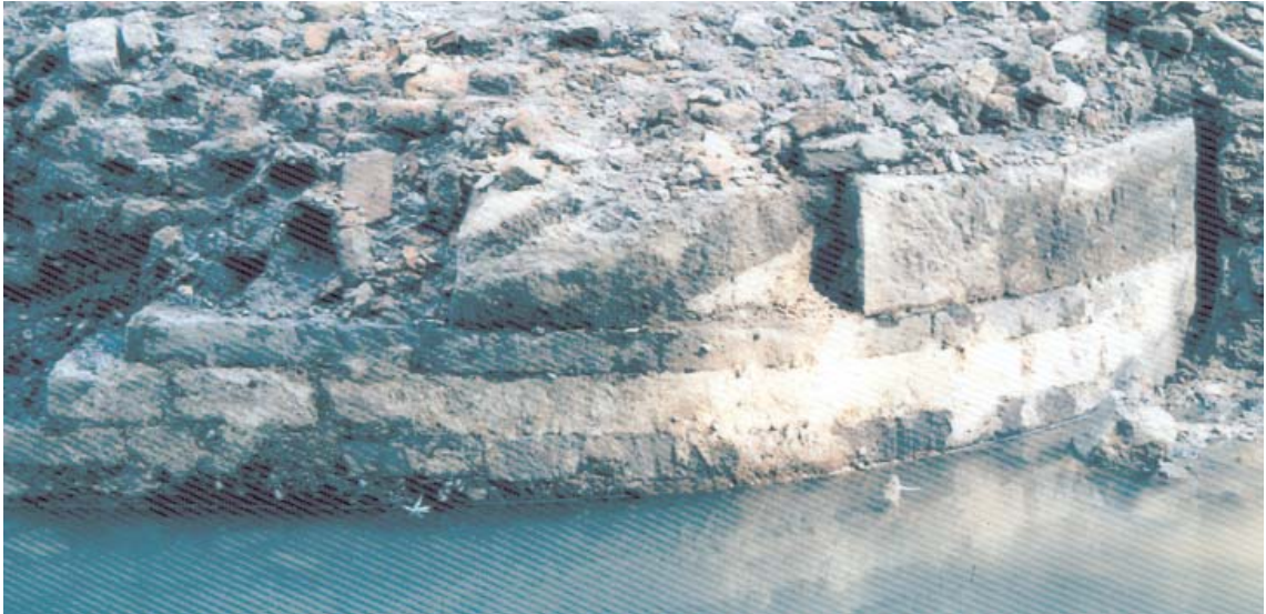
Afb. 16. Natuurstenen buitenschil van de Bartholomeustoren, bestaande uit afwisselend blauwe (Naamse steen) en witte (Iedesteen) natuursteen. Foto Archeologische Werkgroep Schoonhoven.
