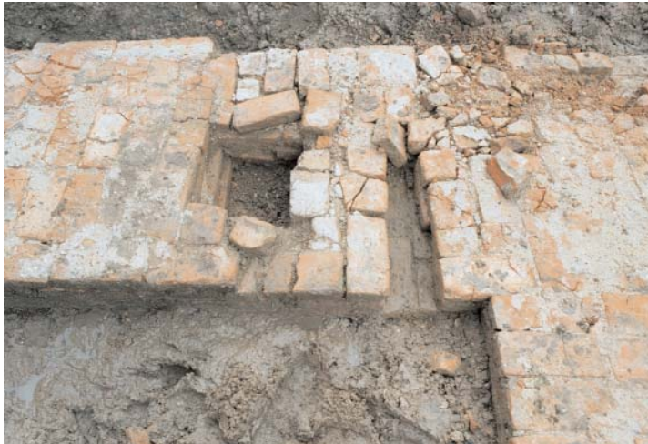
Afb. 14. Detail van de middeleeuwse stadsmuur waarin primair een verticaal gat is vrijgelaten. De functie hiervan is onbekend.
