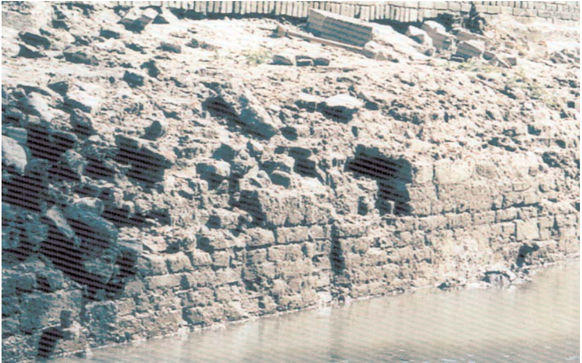
Afb. 18. Detail van de westelijke buitenzijde van de Bartholomeustoren met daarin duimen voor mogelijk een afsluiting van de haven. Foto Archeologische Werkgroep Schoonhoven.
