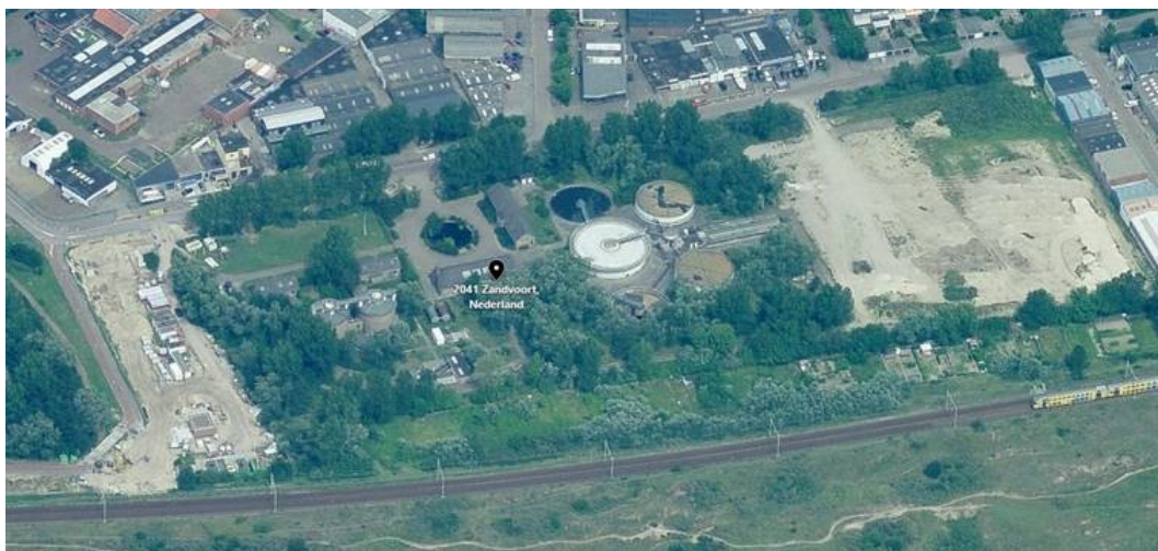
Figuur 24: Luchtfoto voor de sloop van de zuiveringsinstallatie.
