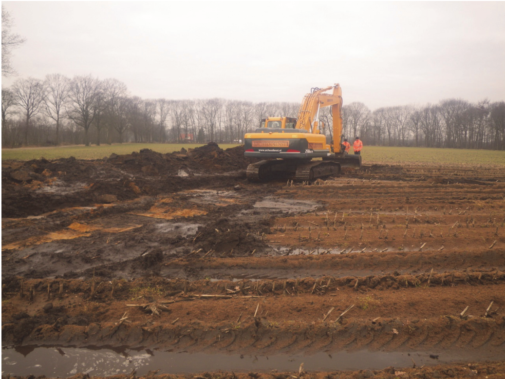
Fig. 1.2: Het plangebied tijdens de werkzaamheden.
