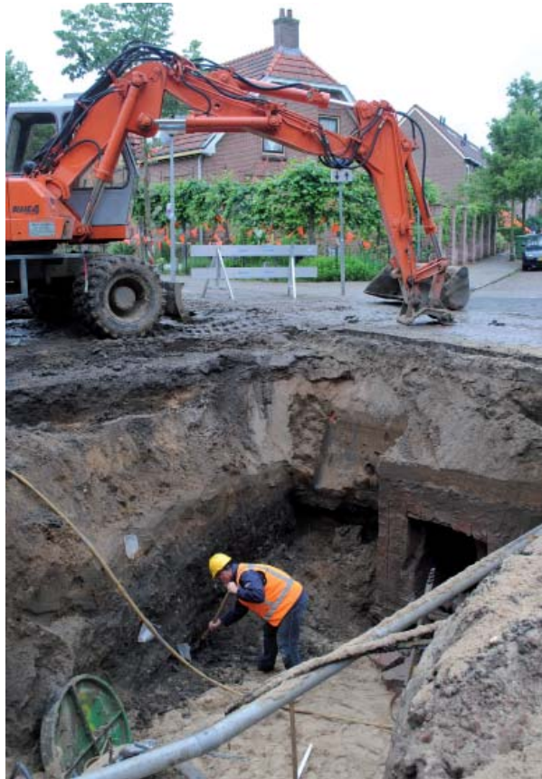
3. Opschaven van een profiel onder in de rioolsleuf.
