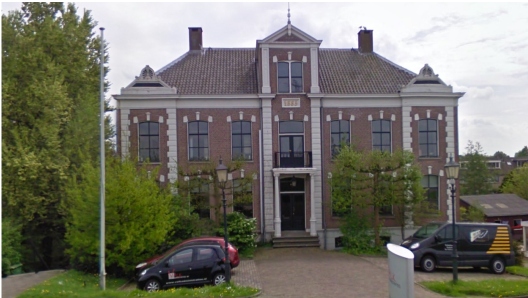
Figuur 4: Het pand aan het adres Lekdijk 354 te Nieuw-Lekkerland (Google Street View).
