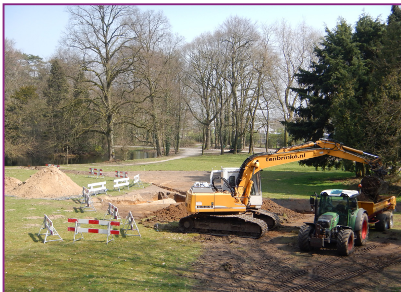
Afbeelding 12: Foto vanaf de stort van de graafwerkzaamheden. In de achtergrond ligt de vijver van waaruit de graafwerkzaamheden zijn begonnen.
