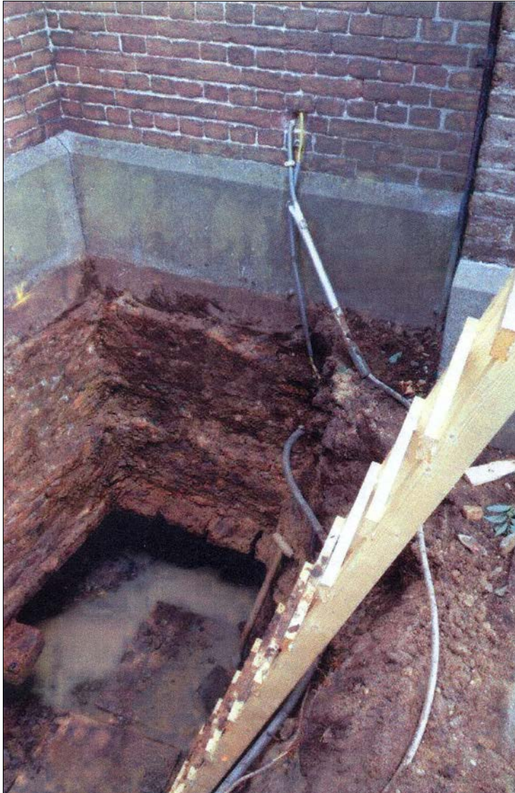
Afbeelding 17. Een van de twee proefputten, die tijdens het funderingsonderzoek in 2013 zijn aangelegd. Bron: C. J. Smit & Zn., 2013.
