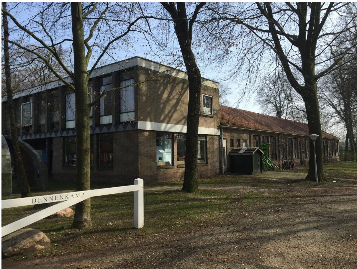
Afbeelding 2.2: Huidige situatie gezien richting het noordoosten.
