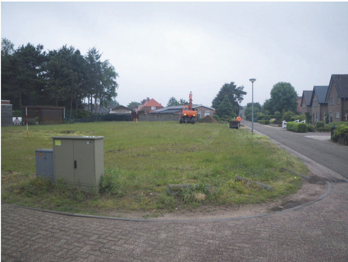
Fig. 1.2: Het plangebied bij aanvang van de werkzaamheden.
