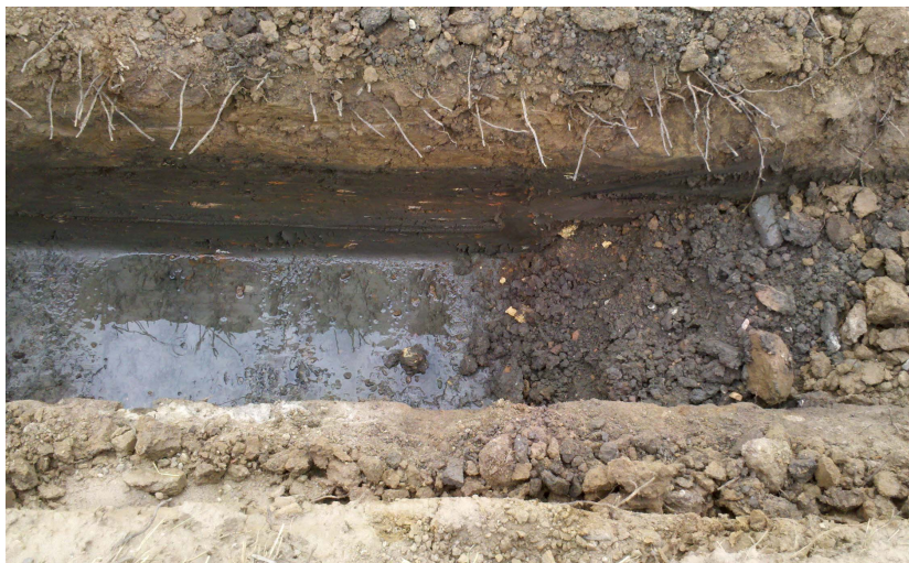
Figuur 5. Langerak, SLA-Dijkversterking: Foto van de gedeeltelijk uitgegraven leidingsleuf. De breedte van het onderste niveau is 40 centimeter. Door kwel stond de bodem vrij snel onder water.
