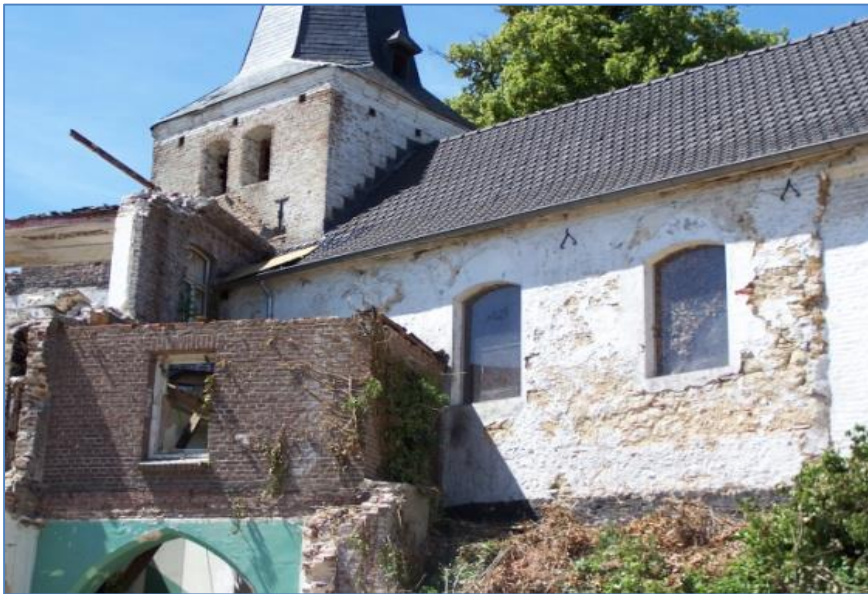
Afb. 9. Noordzijde van het in 2009 in het zicht gekomen muurwerk van de voormalige parochiekerk van Merkelbeek, 12 e eeuw. De kerk staat in de gemeente Brunssum in de buurtschap de Kling. Situatie voor de restauratie van 2014.
