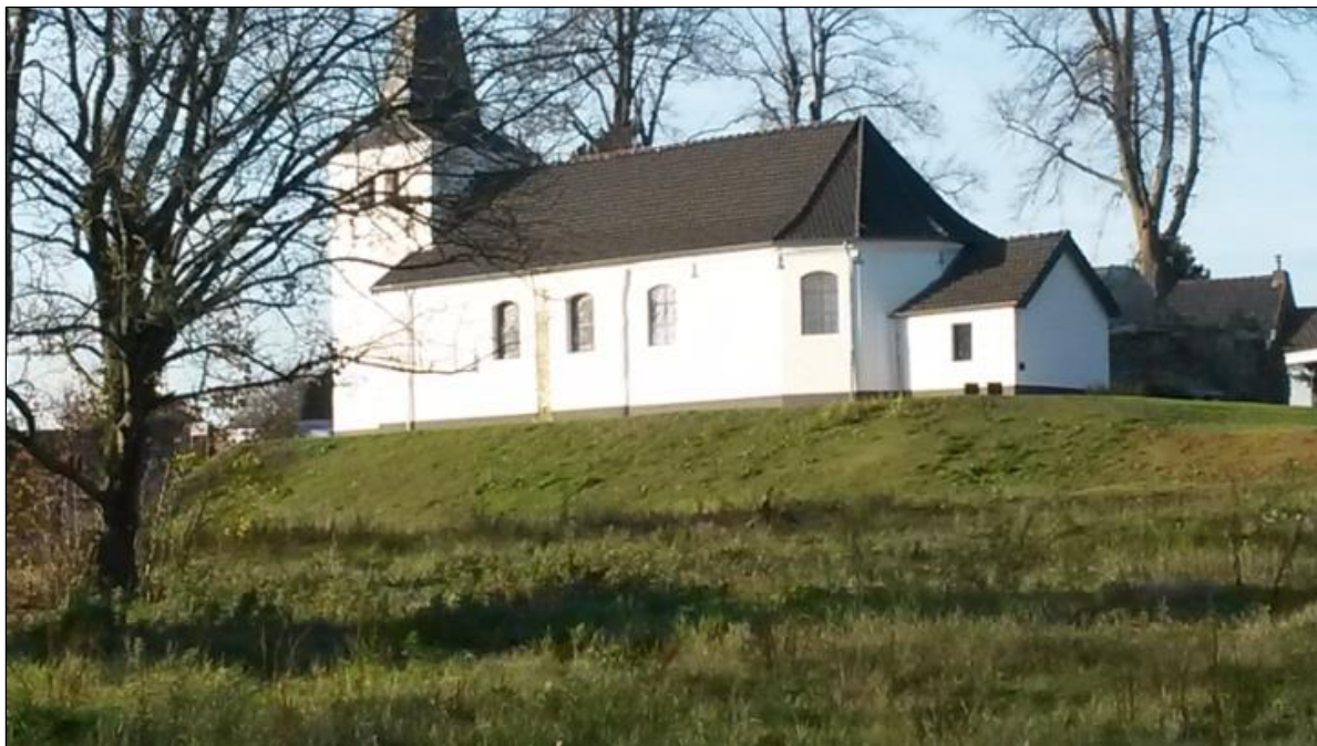
Afb. 20. De Clemenskerk te Merkelbeek na de restauratie, situatie 2014.
