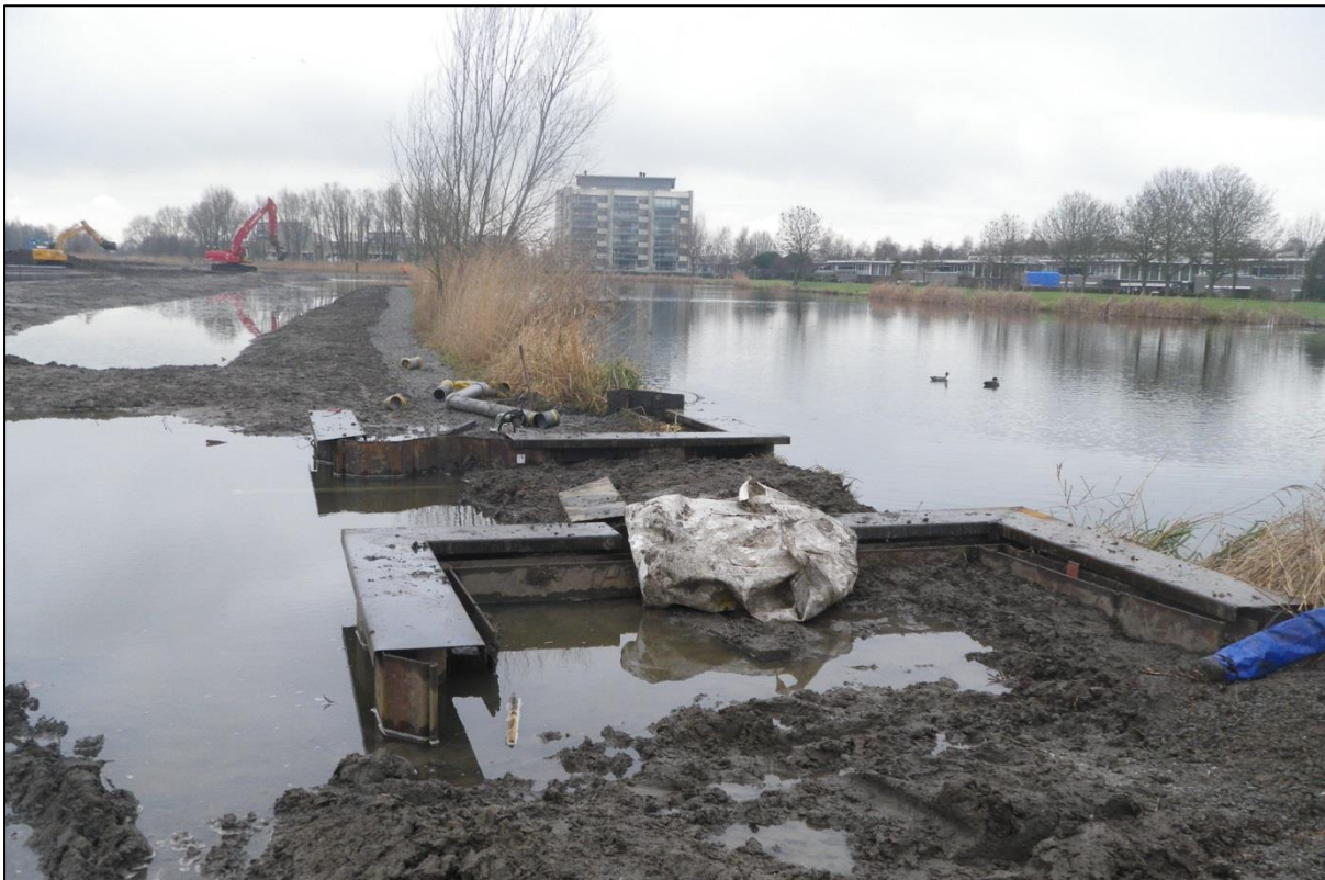
Figuur 3 de zuidelijke doorgang met rechts de vaart en links de nieuw gegraven waterpartijen. In de achtergebleven grond tussen de bruggenhoofden is boring 4 geplaatst.
