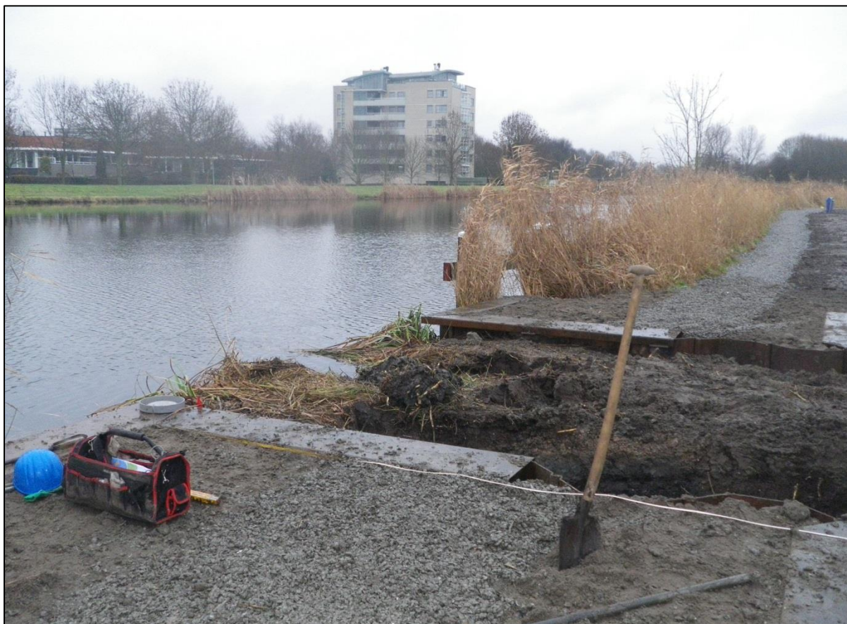
Figuur 2 de noordelijke doorgang voorafgaand aan het weggraven van de grond. Links de vaart en in het midden de profielsleuf.
