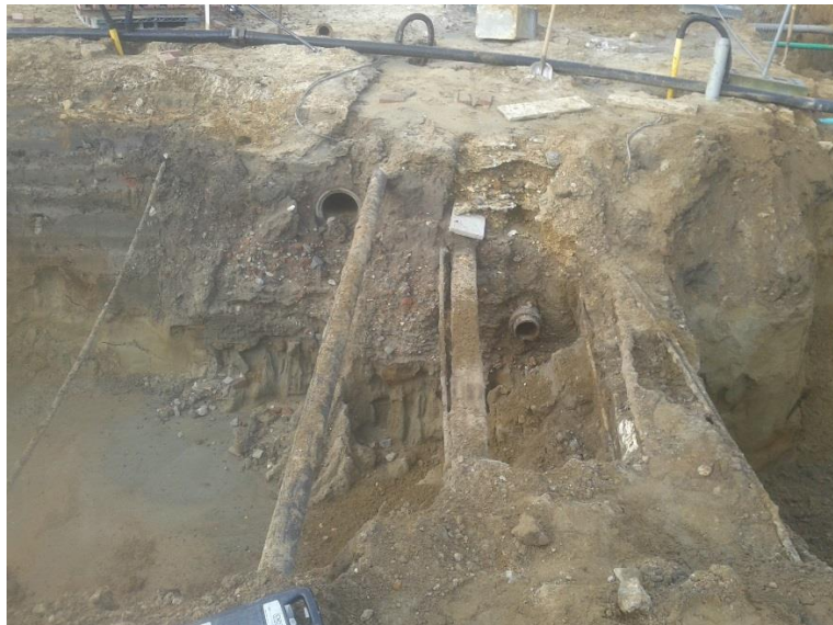
Afbeelding 2. Voorbeeld van verstoorde zone door kabels en leidingen ter hoogte van hoek Marktstraat/Dieterderweg (WP 6).
