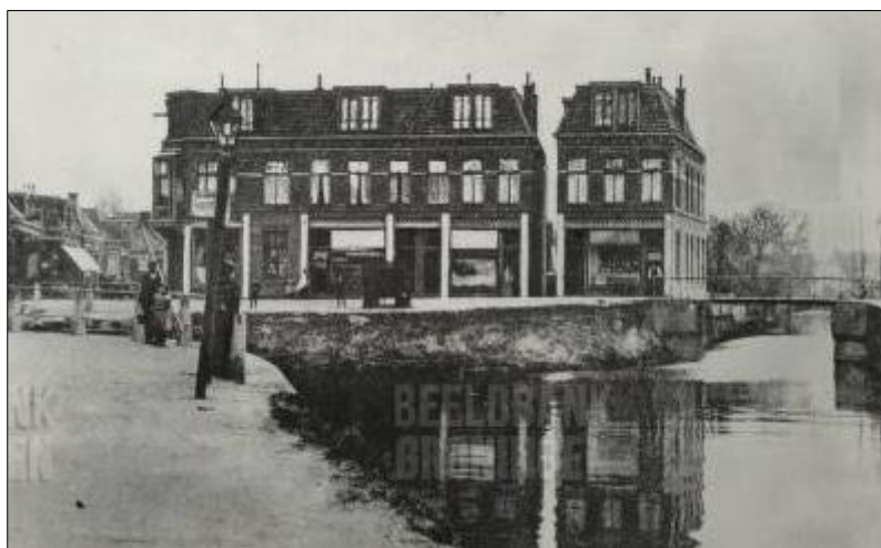
Afbeelding 9. Zicht op 't Kolkje en de Engelstilbrug. Middenin de foto is de stevige kademuur te zien en linksvoor de schuin oplopende wal (bron: www.beeldbankgroningen.nl )
