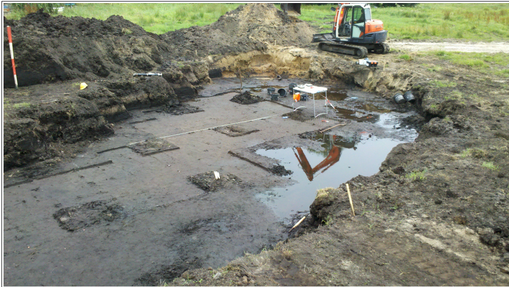
Figuur 8. Terkaple, Roordahiem: De uitvoering van fase 2 van het veldwerk. Rechts is de overlast van grondwater zichtbaar. Links van de graafmachine het gele vulzand van het al ontgraven wegcunet. Foto genomen in zuidoostelijke richting.
