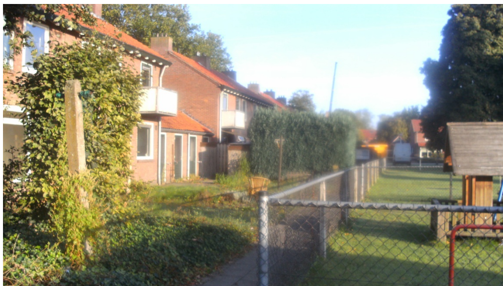
Fig. 3.1: Achterzijde Huenderstraat te Eibergen, foto in westelijke richting genomen.
