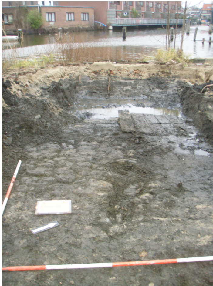
Afb. 4 overzicht aangetroffen helling
