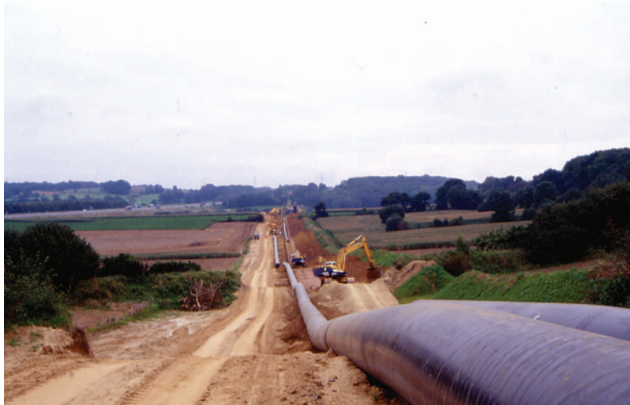
Afb. 3a Het inrijden van de gaspijpen en aanleggen van lasheuveltjes.
