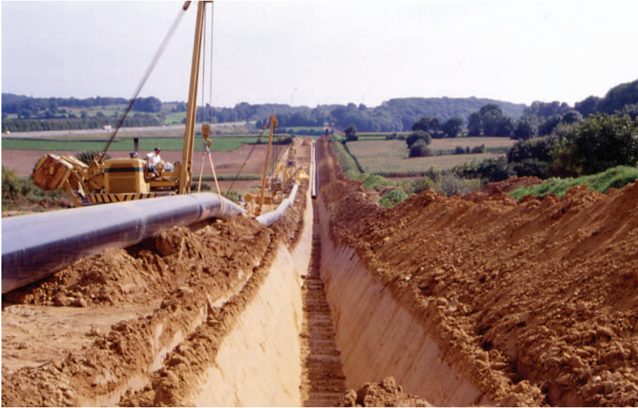
Afb. 3b Het leggen van de pijpen.
