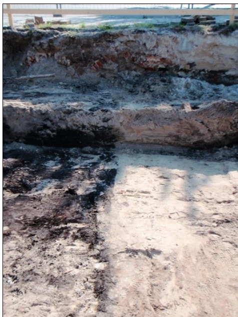
Foto 13. Grondverbetering van de gang tussenkamer 1 en 2 in zuidelijke richting
