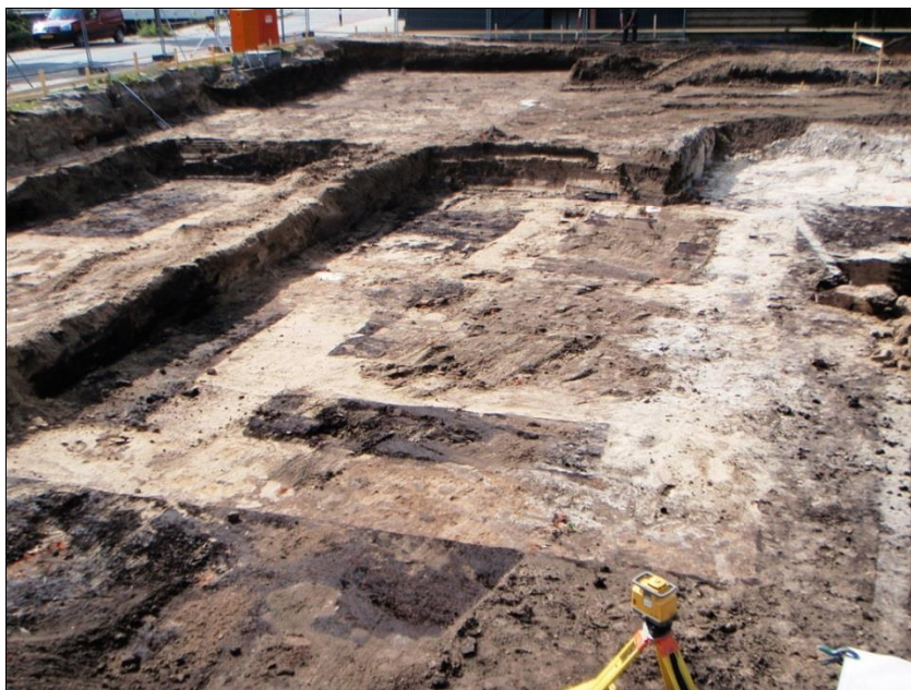
Foto 3. Grondverbetering kamers 6-8 Sorghvliet in zuidwestelijke richting gezien
