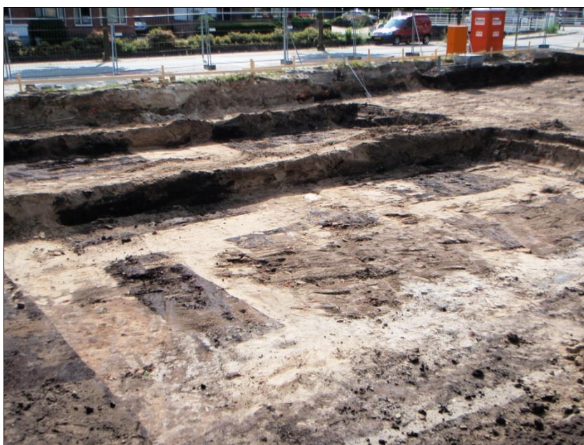
Foto 4. Grondverbeteringen kamers 6-8 Sorghvliet in zuidelijke richting gezien
