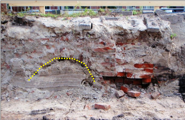
Afbeelding 7. Een beeld van de spaarboogconstructie (gele stippellijn) van de voorgevel van één van de gesloopte gebouwen
