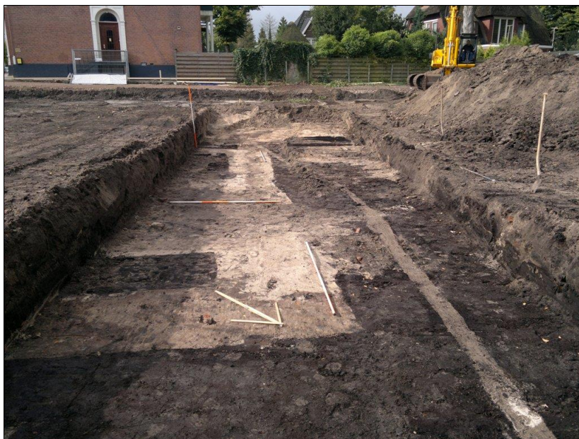
Foto 1. Grondverbetering achtergevel Sorghvliet, in zuidelijke richting
