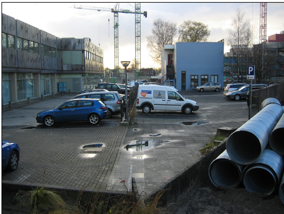
Afb. 4 Huidige situatie van het plangebied: Saentower gezien vanuit het zuidwesten (boven); het gedeelte langs De Vaart gezien vanuit noordelijke richting (onder)
