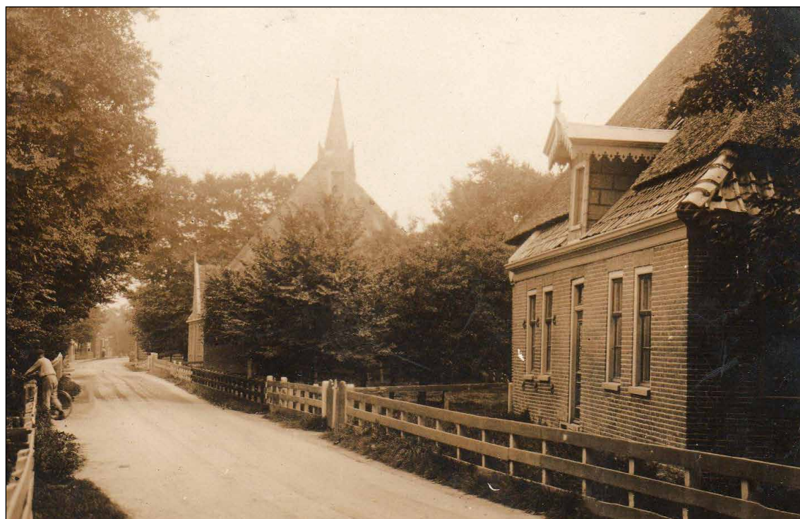
Afbeelding 37. Ansichtkaart met de boerderij Kerkebuurt 190 erop. De "spiegel" van het dak met donker geglazuurde dakpannen is hier goed te zien.
