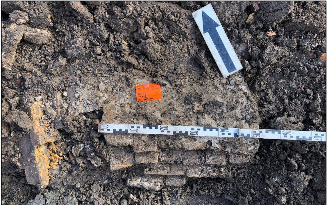
Figuur 10. Restant muurfundering (spoor 1) in werkput 1 vlak 1, bovenaanzicht.
