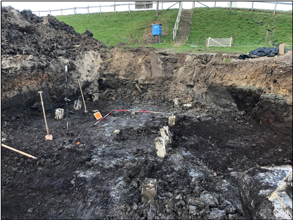
Figuur 6. Betonnen heipalen in vlak 2 van werkput 1.
