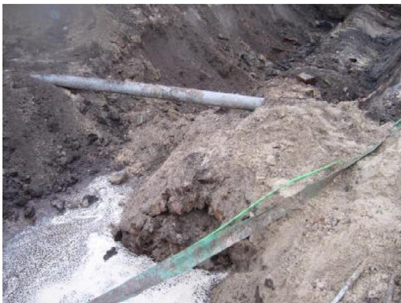
Afbeelding 4: een duiker of resten van een bruggetje van fase 3 tijdens de bodemsanering.
