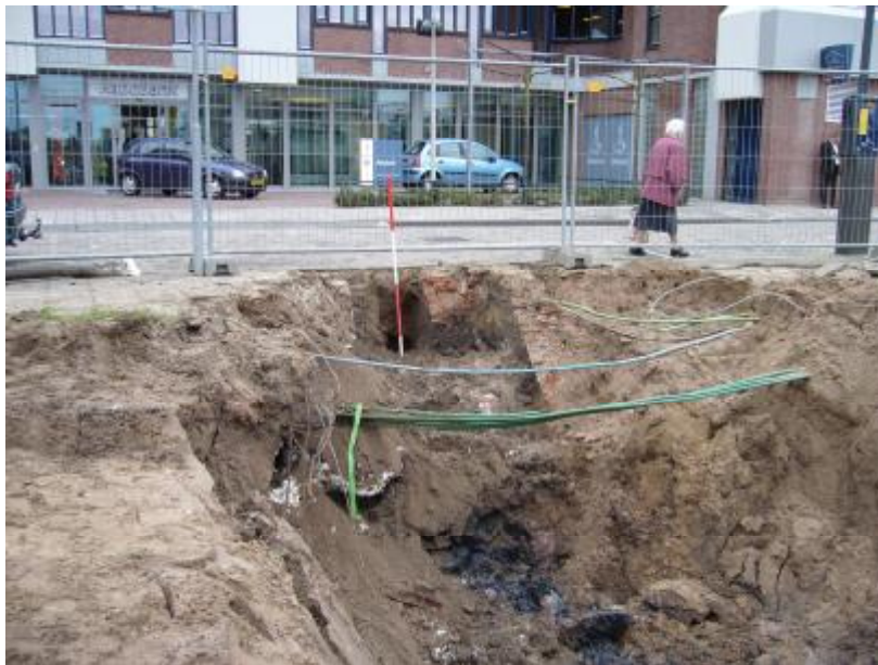
Afbeelding 3: de Loint in fase 3 tijdens de bodemsanering op het Sint Jansplein.
