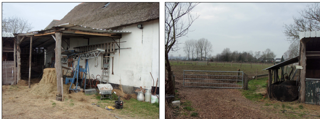
Figuur 3.1 Overzichtsfoto's van de deelgebieden 1 (A: linkerfoto) en 2 (B: rechterfoto), dd. 10-02-2011. A: Foto genomen vanuit het zuidoostelijke deel van deelgebied 1 kijkende in noordwestelijke richting. Op de voorgrond is het te slopen houthok/-schuurtje te zien met aangrenzend erf. B: Foto genomen direct ten zuiden van deelgebied 1 kijkende in de richting van het zuidelijke deel van deelgebied 2 ter plekke van het grasland. Op de foto is zichtbaar dat het maaiveld achter het hek geleidelijk aan oploopt. Het verschil in hoogte tussen deelgebied 1 en 2 betreft circa 40 cm.
