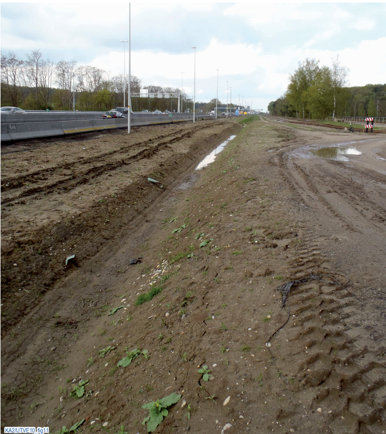
Figuur 11. Overzicht slootkant in vak N12 vanaf km 77,2 richting westen.
