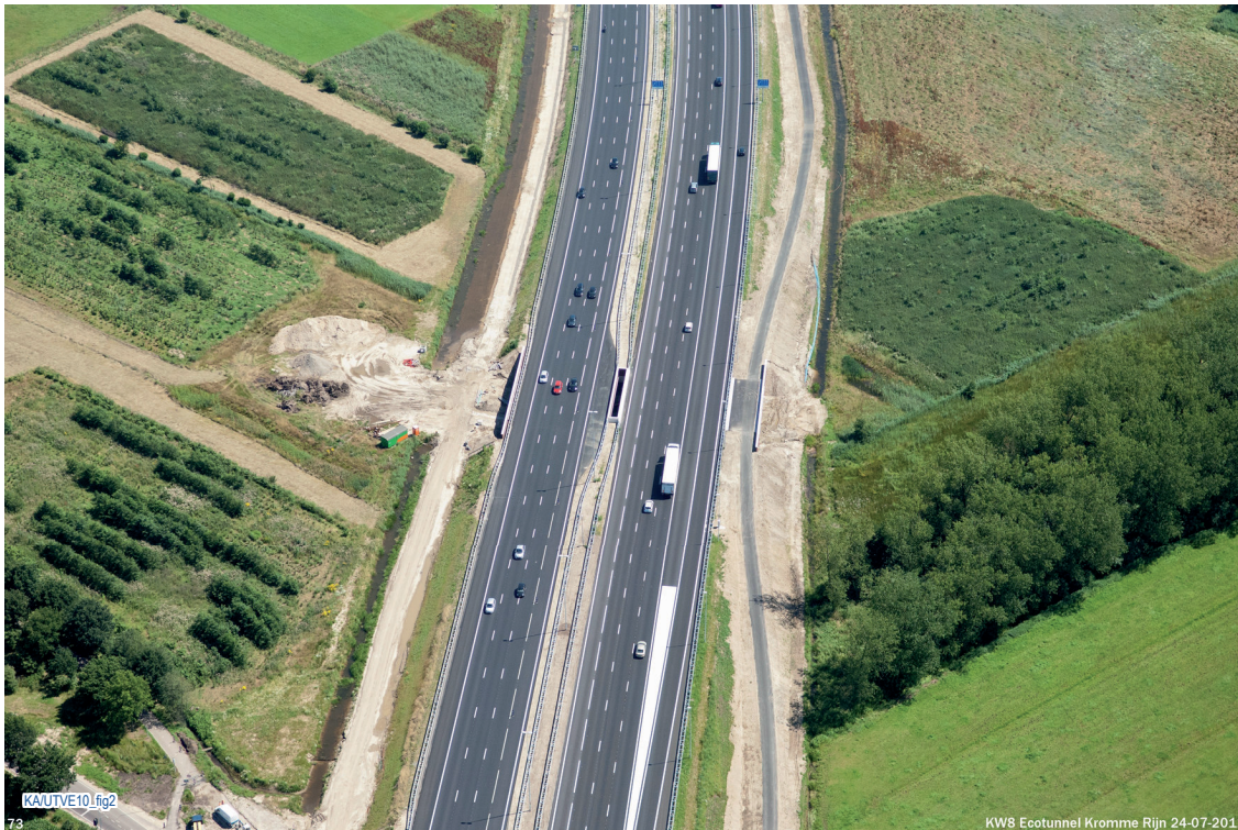
Figuur 2. Luchtfoto van het ecoduct in vak Z06 (foto: Poort van Bunnik).
