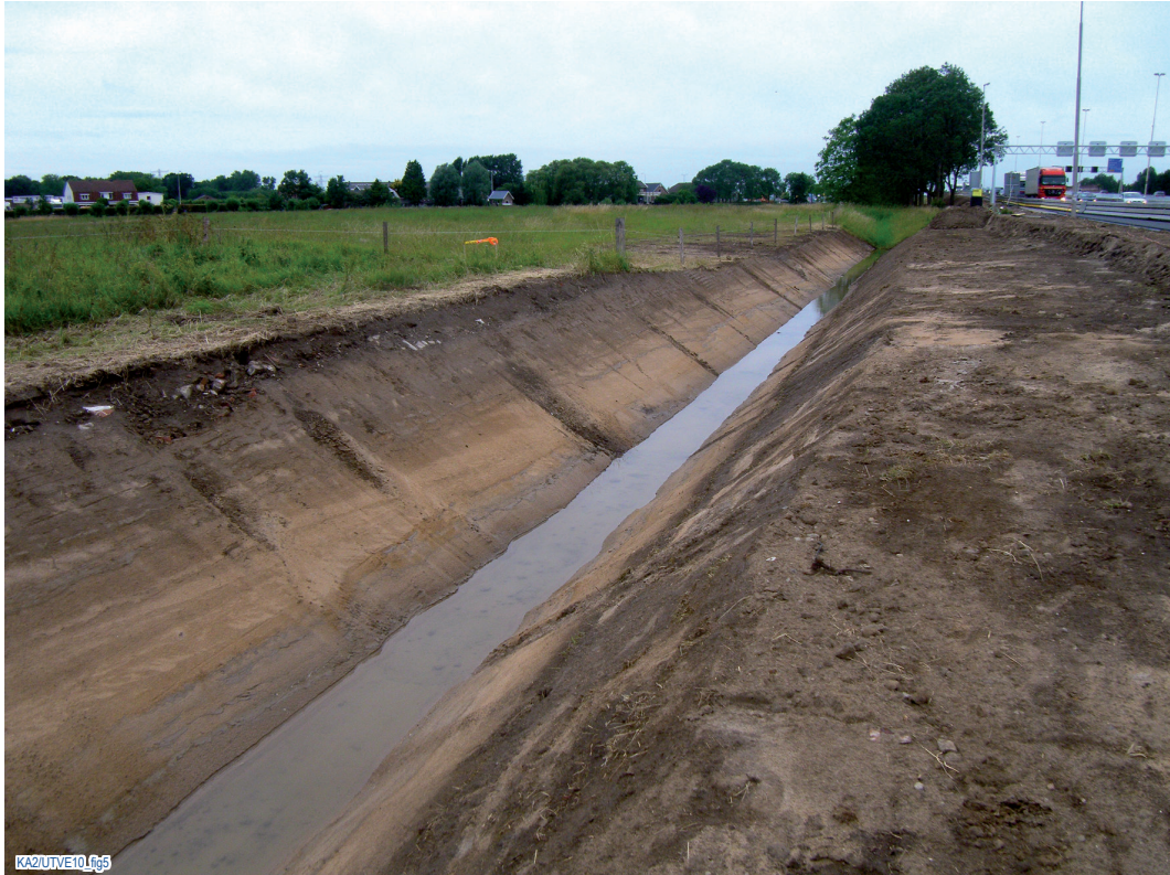
Figuur 5. Overzicht slootkant in vak Z01 vanaf km 68,4 richting westen.
