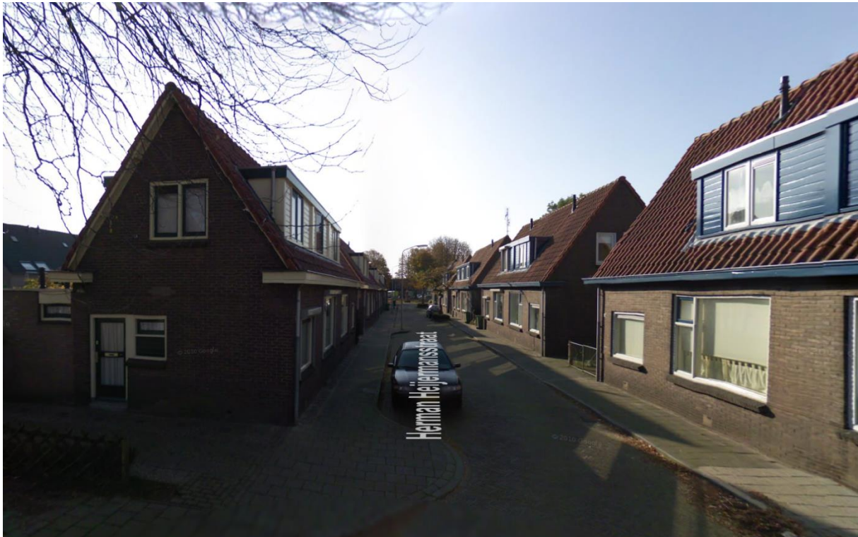
Afb. 5: Huidige situatie Herman Heijermanstraat gezien vanaf het noorden. (bron: Google Earth)
