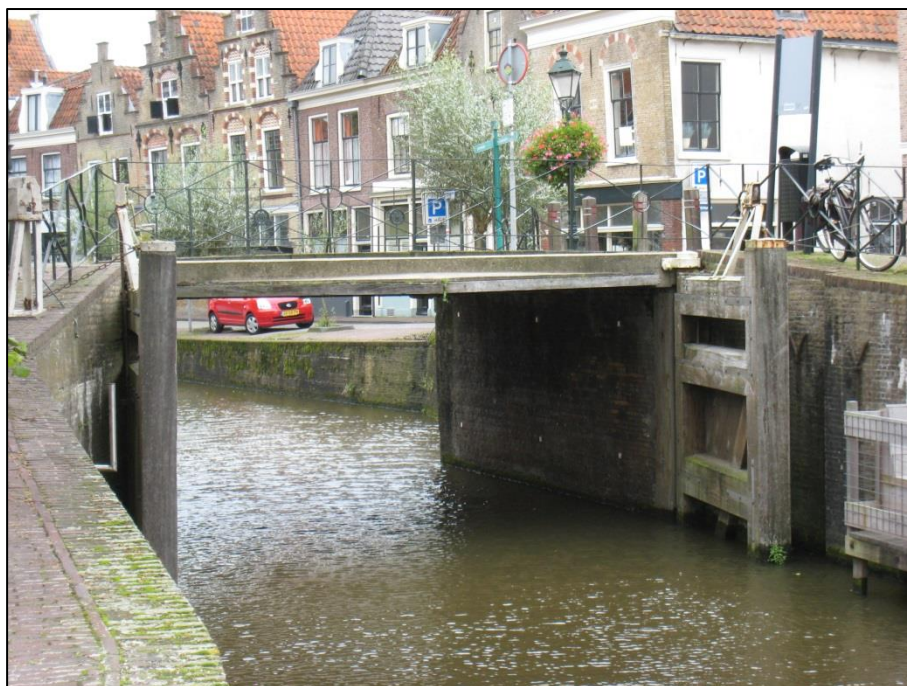
Figuur 2.8 Huidige toestand Romeijnsbrug (foto: J.M.J. Willems, oktober 2017).
