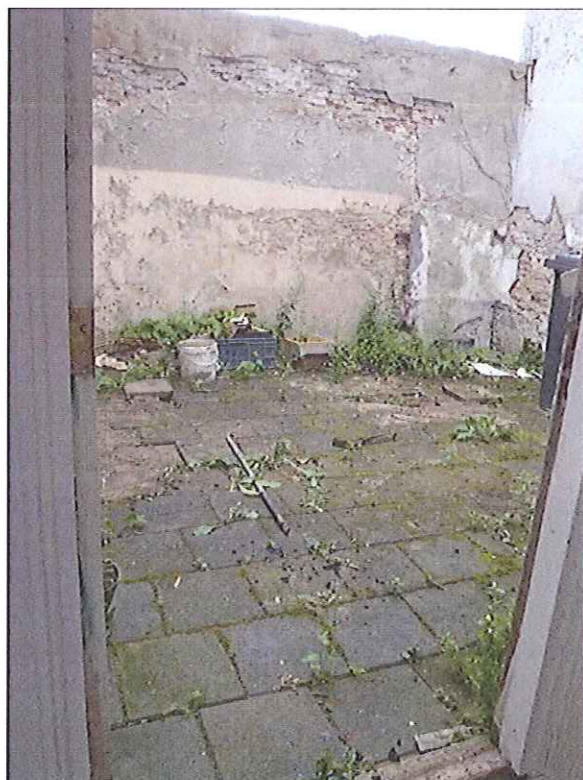
Afbeelding 14. Impressie van de onderzoekslocatie ten tijde van het veldwerk. Te zien is het plaatsje aan de achterzijde van het pand, waar boring 1 is gezet. Gefotografeerd richting het westen.
