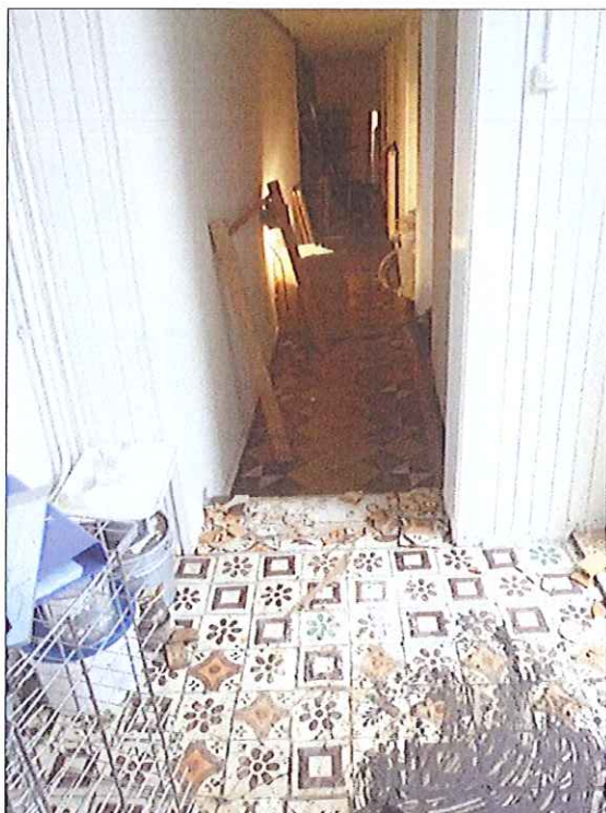
Afbeelding 13. Impressie van de onderzoekslocatie ten tijde van het onderzoek. Op de voorgrond de toilet-/ketelruimte met helemaal vooraan boring 2. Op de achtergrond de langgerekte zijruimte waar de boringen 4 t/m 6 zijn gezet. Gefotografeerd richting het zuiden.
