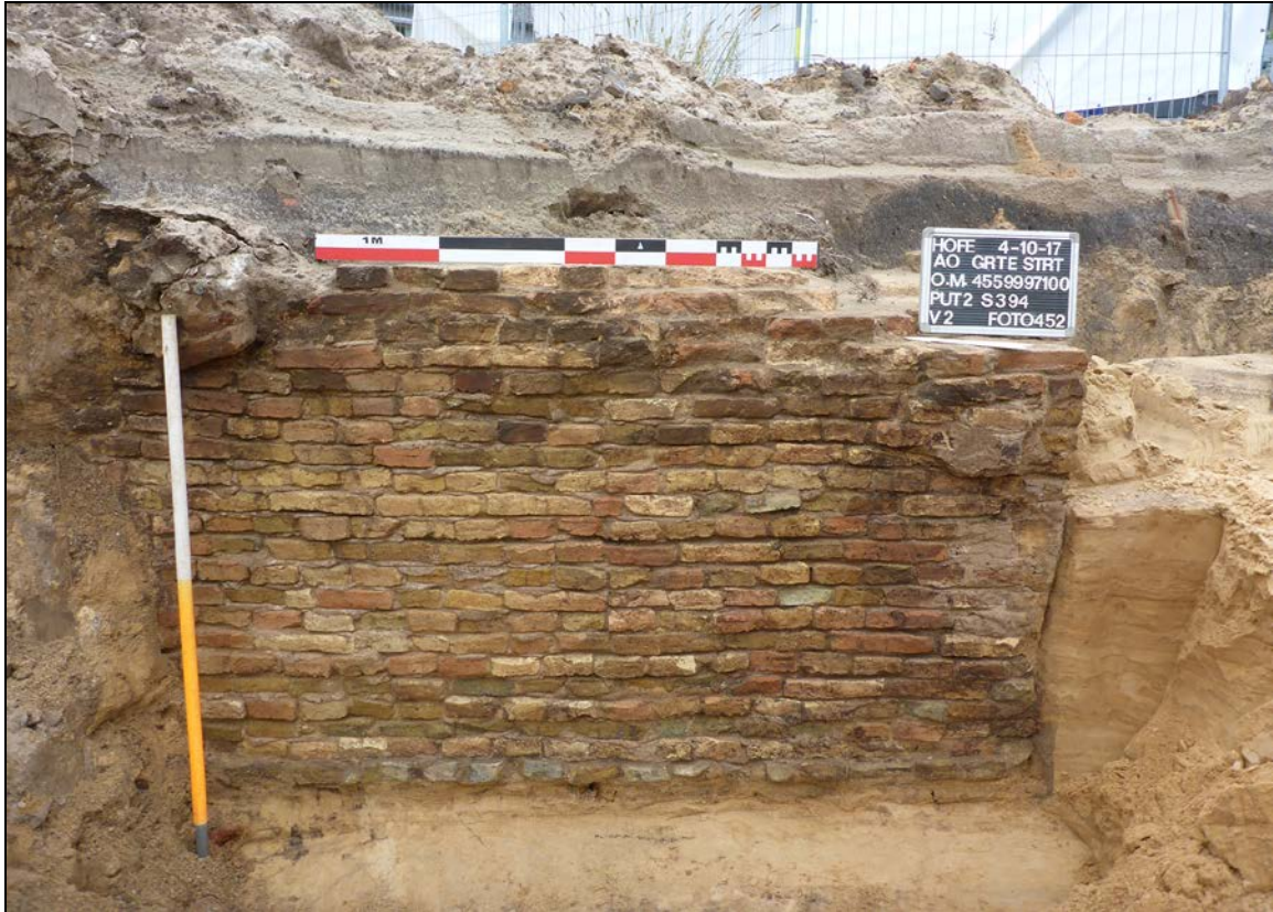
Afbeelding 4.56. De keldermuur (Spoor nr. 394) van Structuur nr. 4 uit het midden van de 19 de eeuw, in het noordelijke profiel (Profiel 1) van Put nr. 2. De foto (Foto nr. 452) is genomen van uit zuidwestelijke richting.
