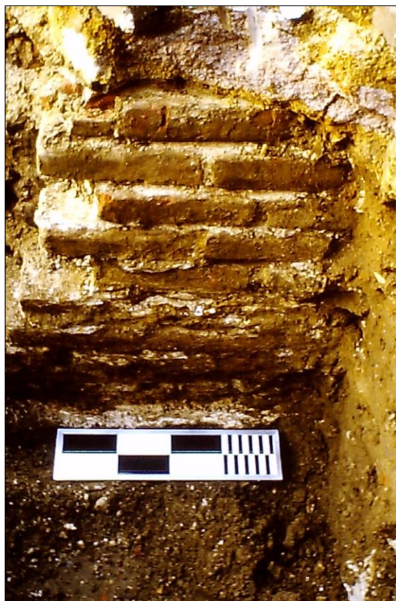
Figuur 8. Aanzicht van de fundering B, in schoonmetselwerk, strekken en regelmatig verband. Foto's: Alfons Bruekers.
