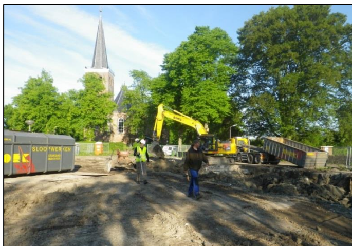
Afbeelding 2. Overzichtsfoto van de werkzaamheden. Aan het begin van de opgraving wordt het laatste materiaal van de sloper van het plangebied verwijderd.
