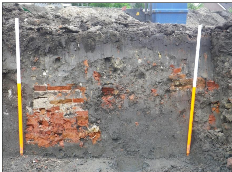
Afbeelding 13. Het muurrestant in het profiel van één van de saneringsputten (links), achtergelaten door de sloop-aannemer. De muur representeert waarschijnlijk de achterwand van de schuur van de historische boerderij.
