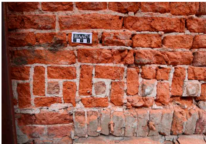
Detail van het decoratieve fries met baksteen koppen rond een bakstenen vierkant. (Foto: M. van Dam, BAAC)
